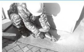
適切な切り込みを入れたのち、電動ハンマーを用いて削り出しを行います。
