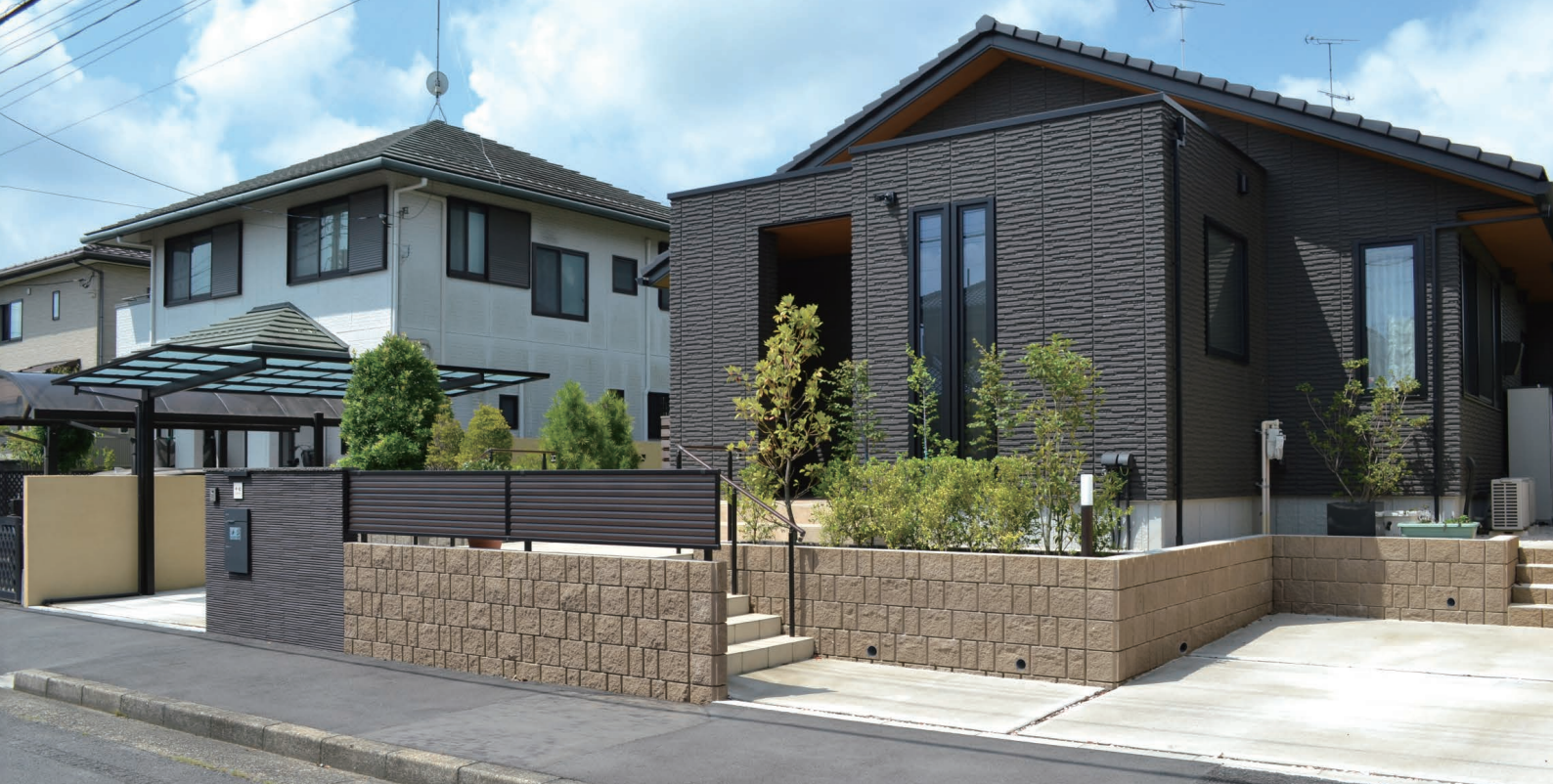
ナチュラルブラウン ※擁壁にはRECOM 2SPを使用しています。
