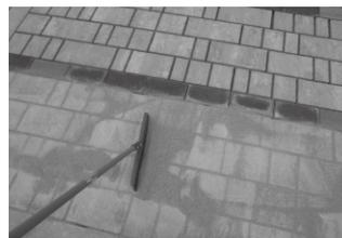
※SBサンドIIをまとめて出して、ほうき等で移動すると材料分離が生じて固定化不良の原因となります。
