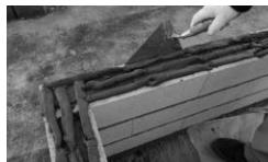
ブロックの上にモルタルを置きます。ブリエトップの据え付け後に、本体下部の空間にモルタルが充てんされるよう、十分にモルタルを盛ります。
