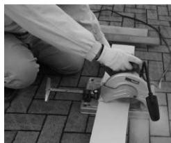
図面、および施工箇所の寸法を確認し、電動丸のこ(ダイヤモンドチップソー)でブリエトップを切断します。切断の際、切断機のクランプや、丸のこのベースで傷が付かないように緩衝材等で養生をしてください。
