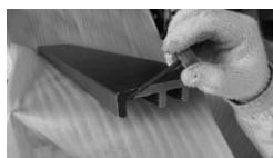
水止めシーラーが乾いたら、その上に補修ペイントを塗布します。下地の汚れをよく拭き取り、補修ペイントの容器をよく振って、直接タッチアップしてください。
