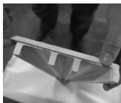
ブリエトップを2本以上連続させる場合には、ブリエトップ同士が接する箇所の片側にゴムスponジ目地を貼り付けます。ゴムスponジ目地を押しつぶすようにしながら、2本目以降のブリエトップを据え付けます。
