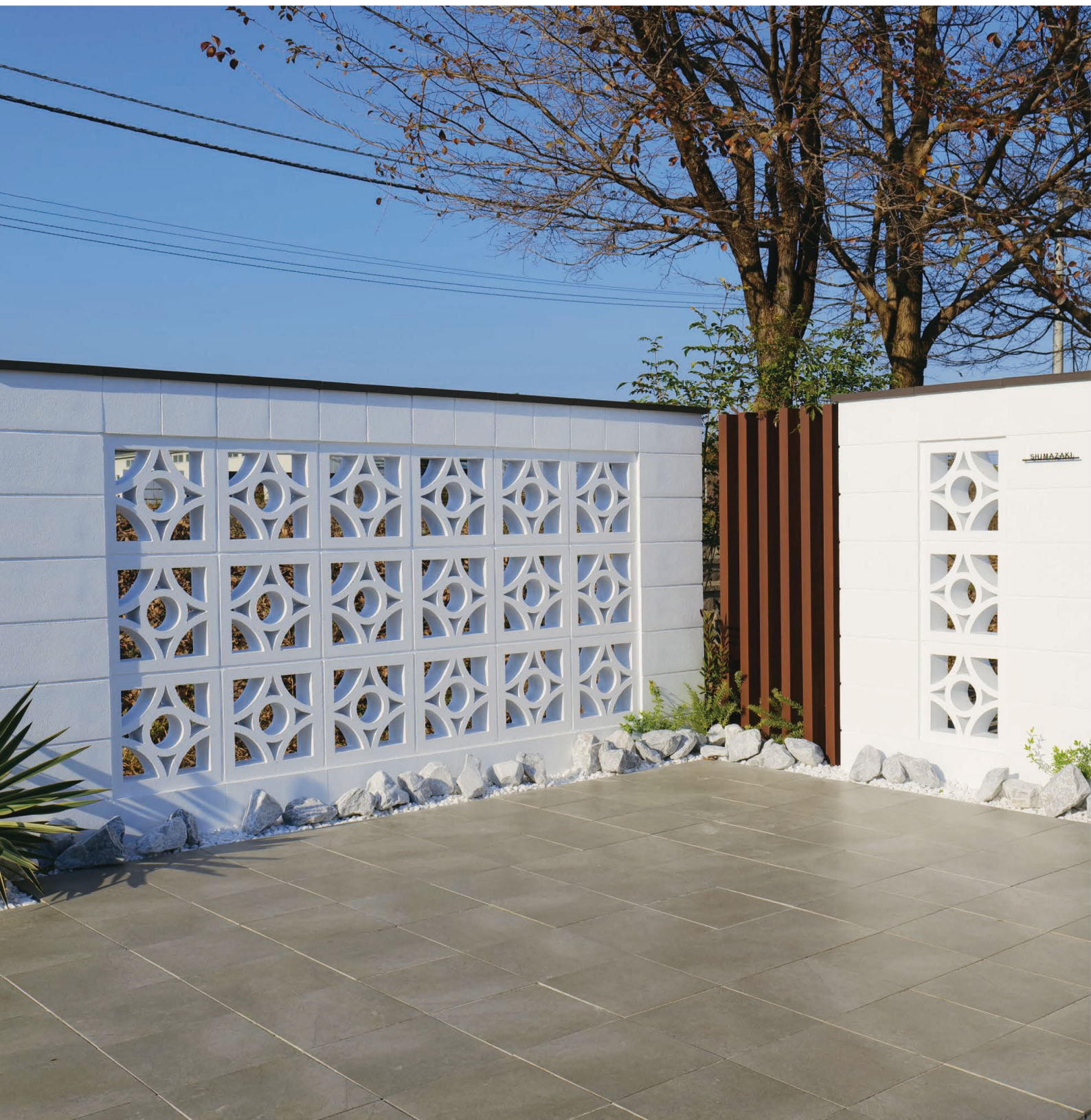
※写真の製品は、現場にて塗装しています。
