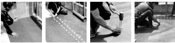
②-1 敷設開始 ②-2 重ね代100mm ②-3 仮固定 ②-4 スミ付け
