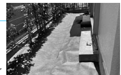
③-1 シート敷設完了
